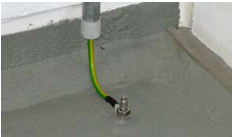
Abb. 37 Beispiel Erdungsanschluss für ableitfähigen Fußboden
