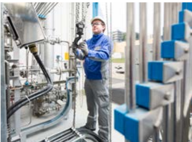
Abb. 27 Hebezeuge sind regelmäßig zu prüfen
