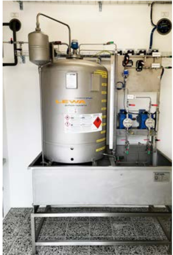
Abb. 13 Odorieranlage
