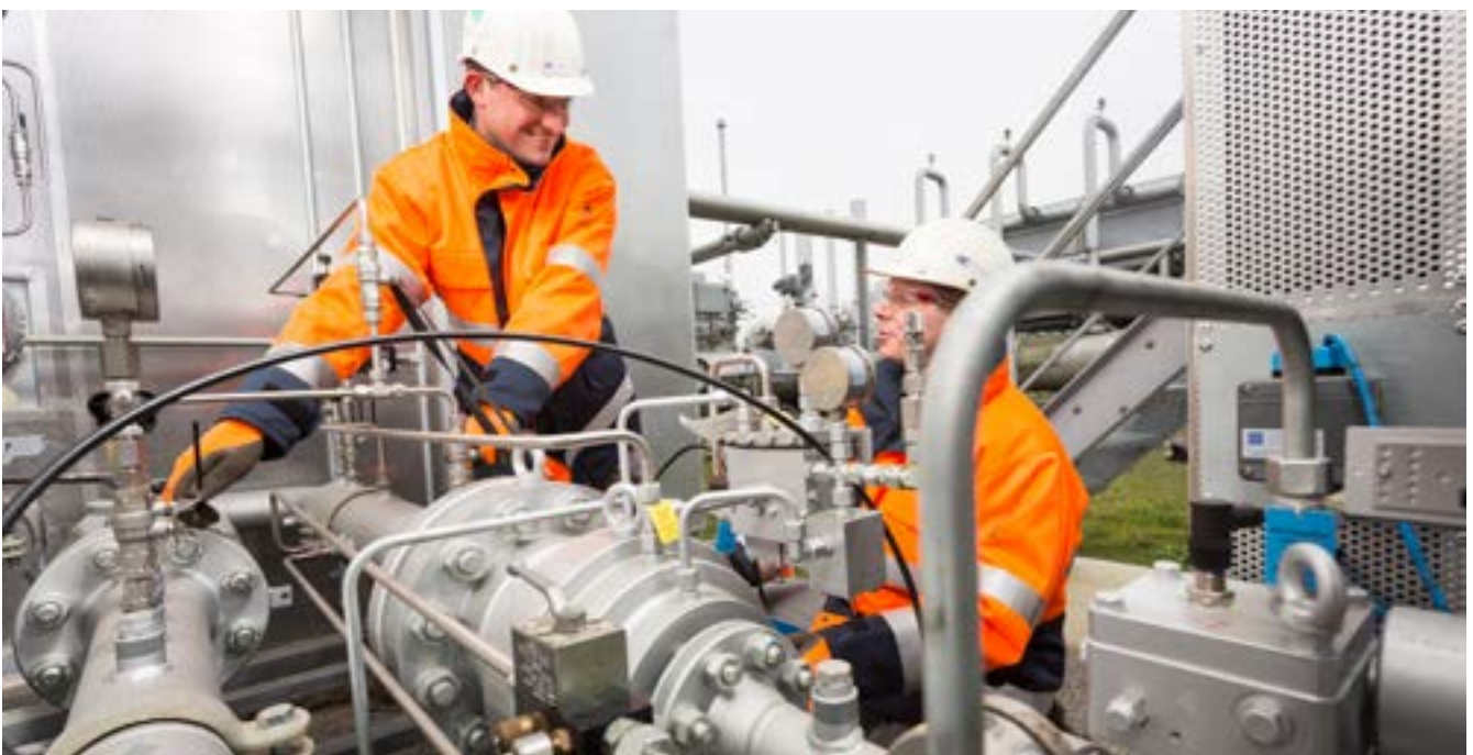
Abb. 8 Instandhaltungsarbeiten in einer GDRM-Anlage
