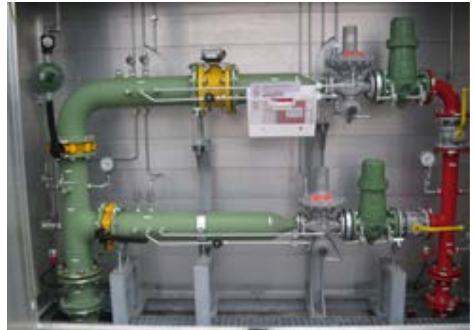
Abb. 15 GDRM-Schrankanlage
