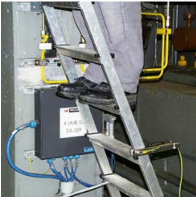
Abb. 42 Erdung einer mobilen Einrichtung (Stehleiter)
